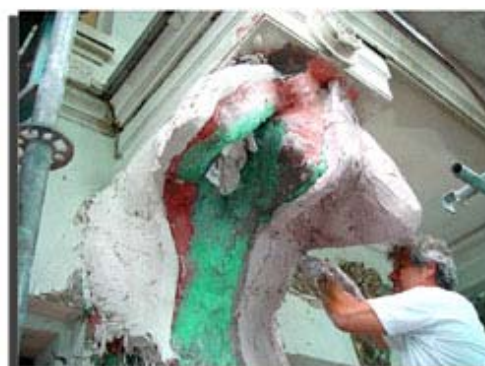
Kappen om de mal zijn stevigheid te geven, worden gemaakt.
