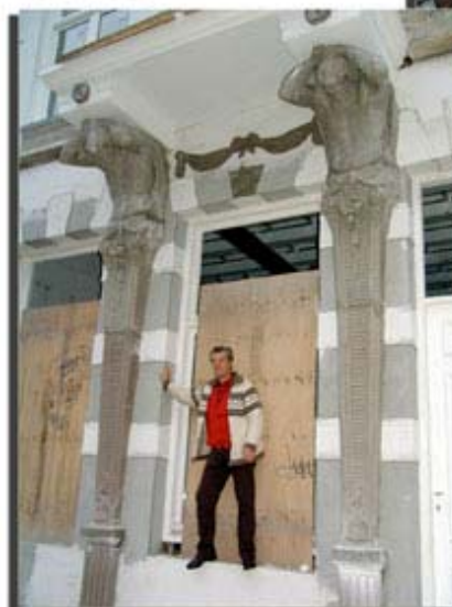
De gietsels zijn dun en licht, kunnen diengevolge over iets heengeplaatst worden.
