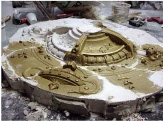
Door middel van mallen, de ontbrekende stukken gekopieerd
